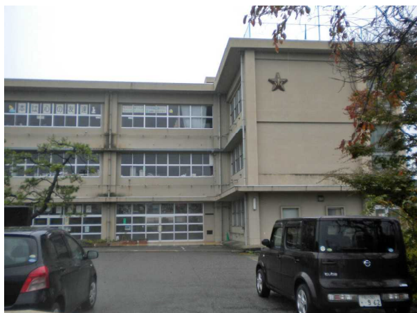
七尾市・小丸山小学校の校舎
