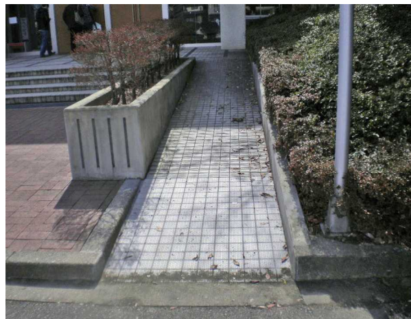
正面玄関に設置されたスロープ
