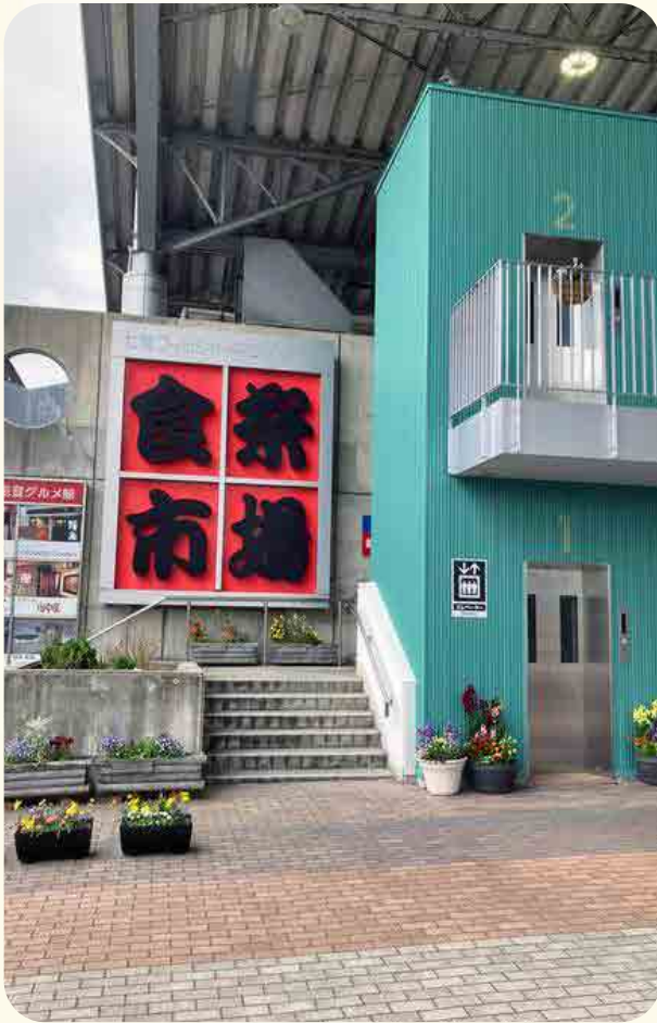
正面の階段横に新エレベーター
