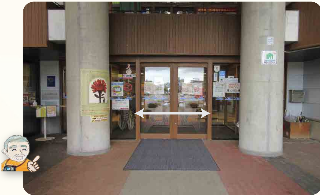
正面玄関の扉幅：168cm
