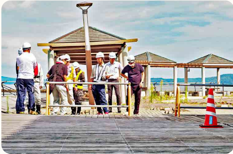
工事関係者が被害状況を視察
