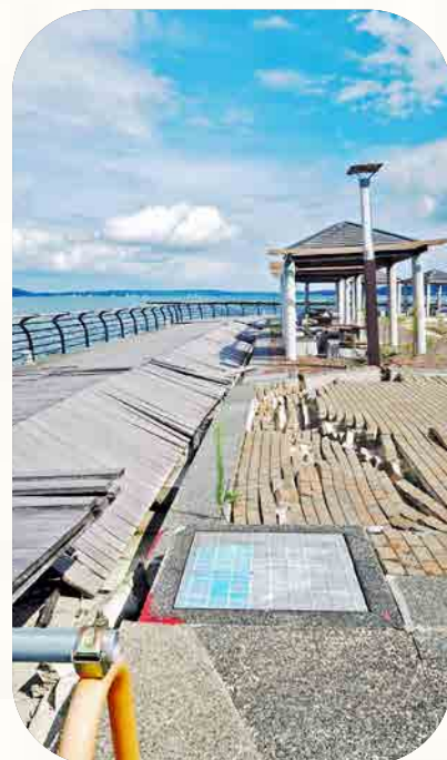
休憩場所の床敷きの煉瓦がひび割れを起こしている
