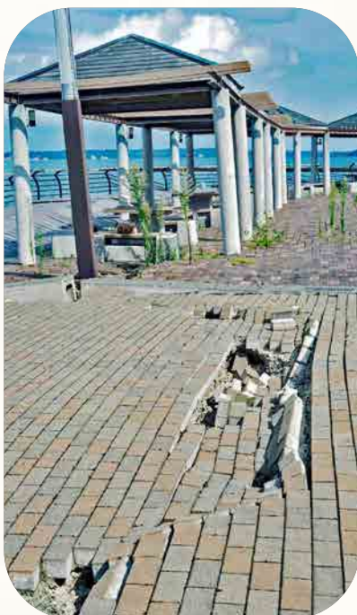
休憩場所の床敷きの煉瓦がひび割れを起こしている
