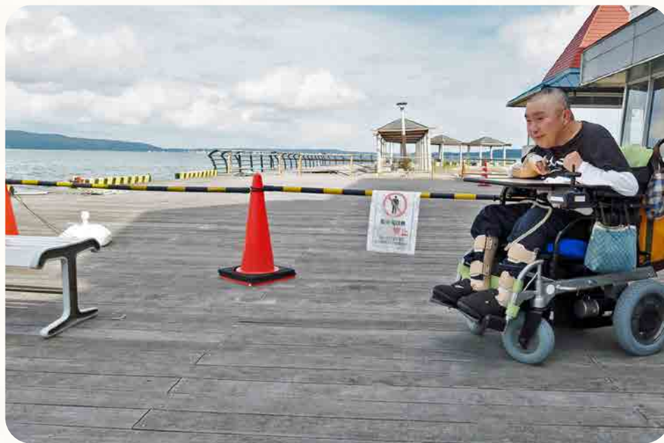
七尾マリンパーク側へ出ると、ひどい地割れ
