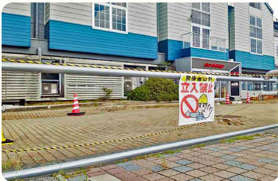
破壊した通路は危険なので「立入禁止」
