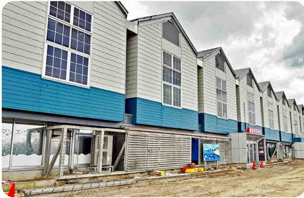
能登生鮮市場側の地震で破壊した通路
