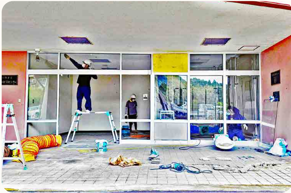
正面玄関の扉等の復旧工事を行っている
