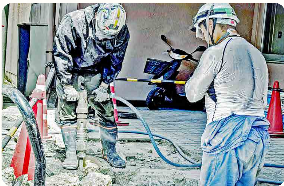
床張りを掘り起こして、復旧工事
