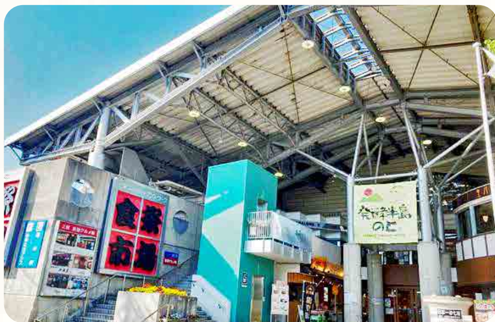
新エレベーターは食祭市場の正面玄関にあります
