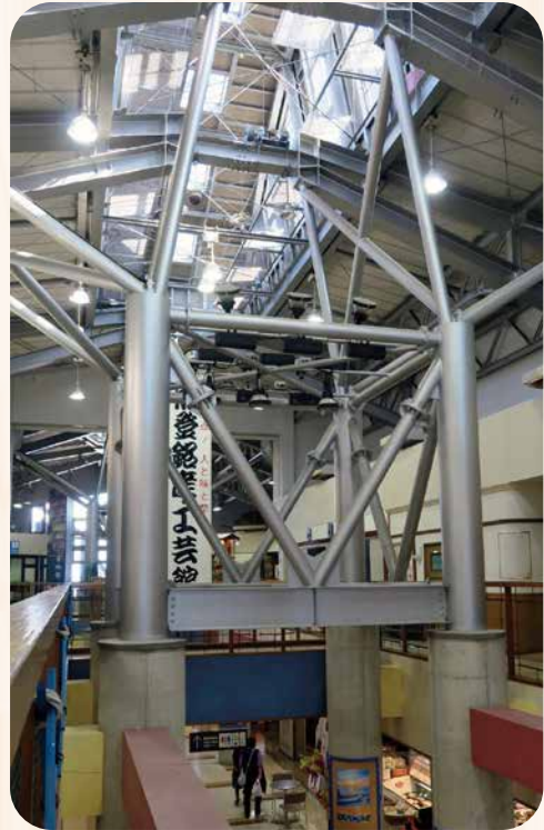
正面からの二階、吹き抜け
