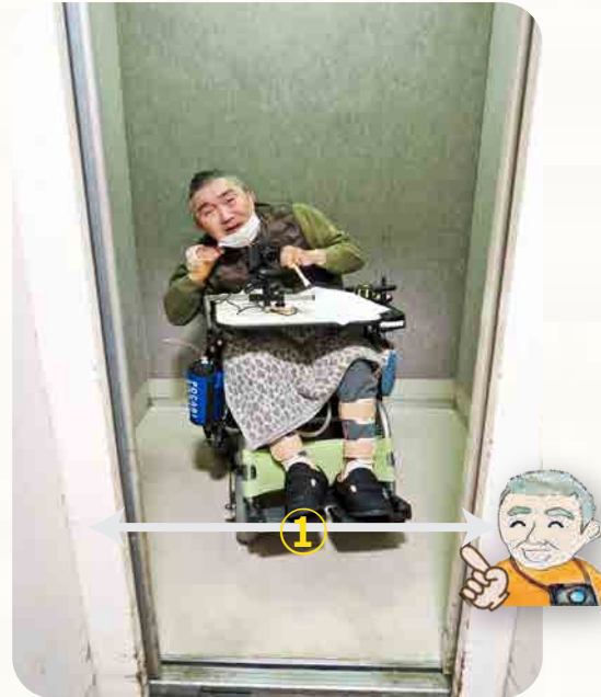
①旧エレベーターの乗降口幅は80cm。旧エレベーターの操作ボタンは位置が高く、届かない
