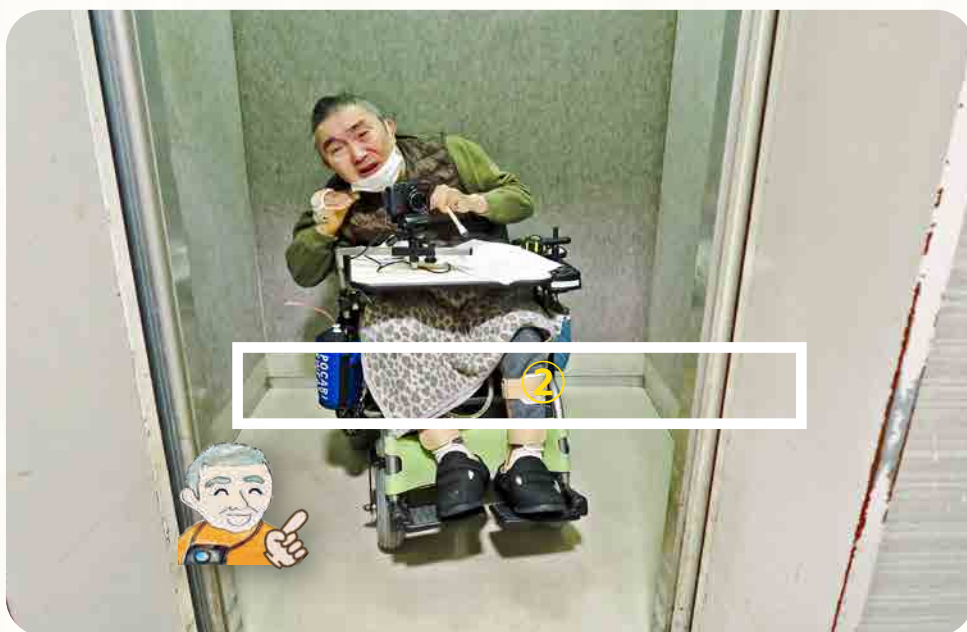
②旧エレベーターの床面積、140×140cm
