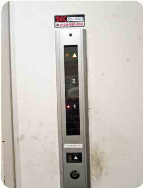
①旧エレベーターの乗降口幅は80cm。旧エレベーターの操作ボタンは位置が高く、届かない
