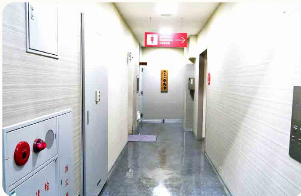
2階「株式会社 香島津」事務所前の通路に旧エレベーター
