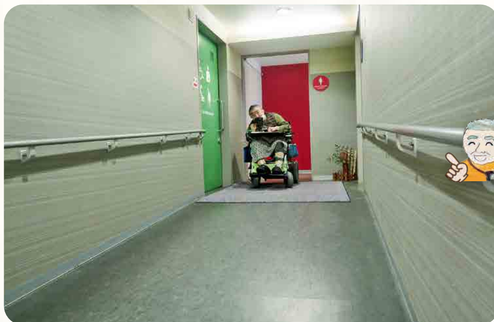
多目的トイレへ行くまでのスロープを設置
