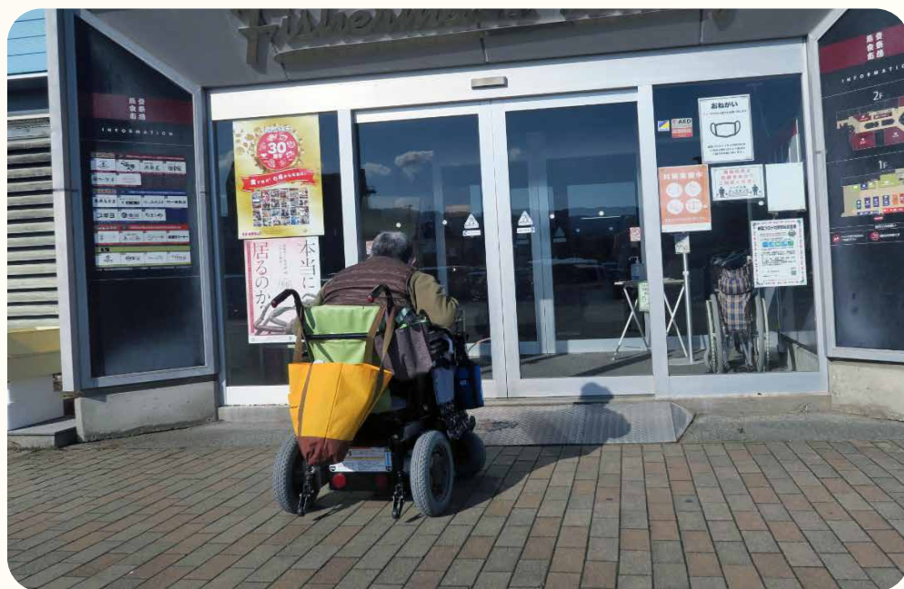
水産部入口より入店。入口の戸口の幅が 250cm 。スロープあり
