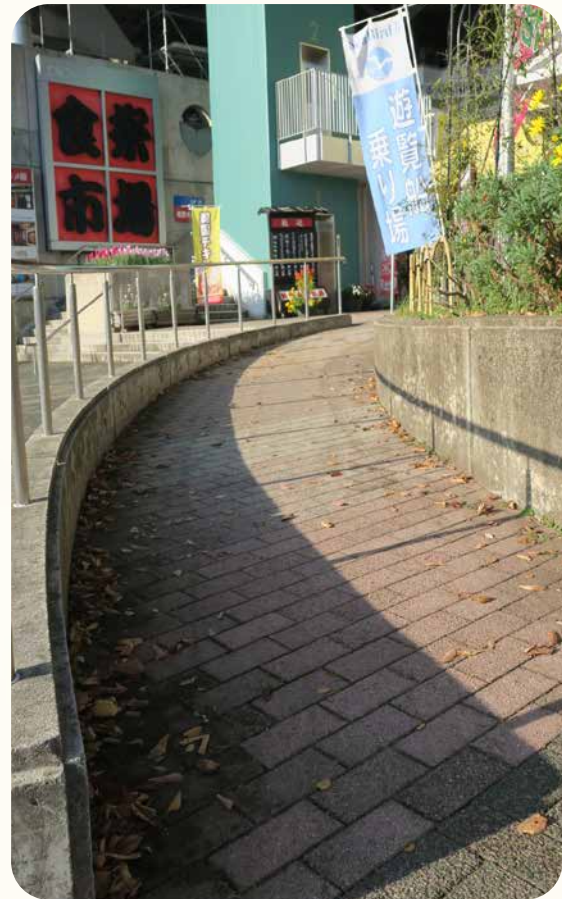
正面玄関に向かうスロープ（全体）
