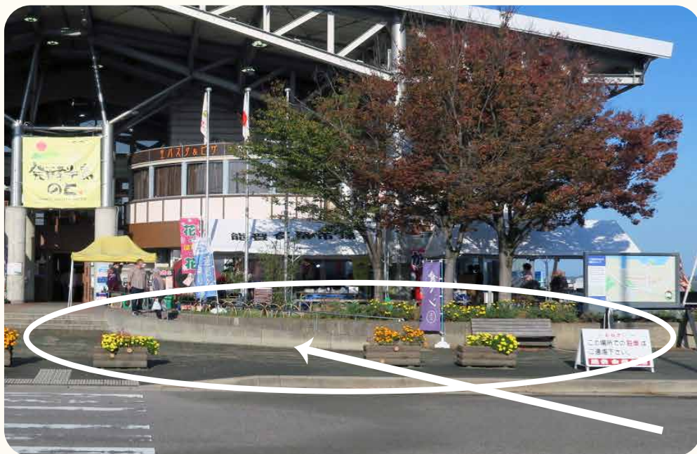
正面のスロープ、登りの正面玄関前
