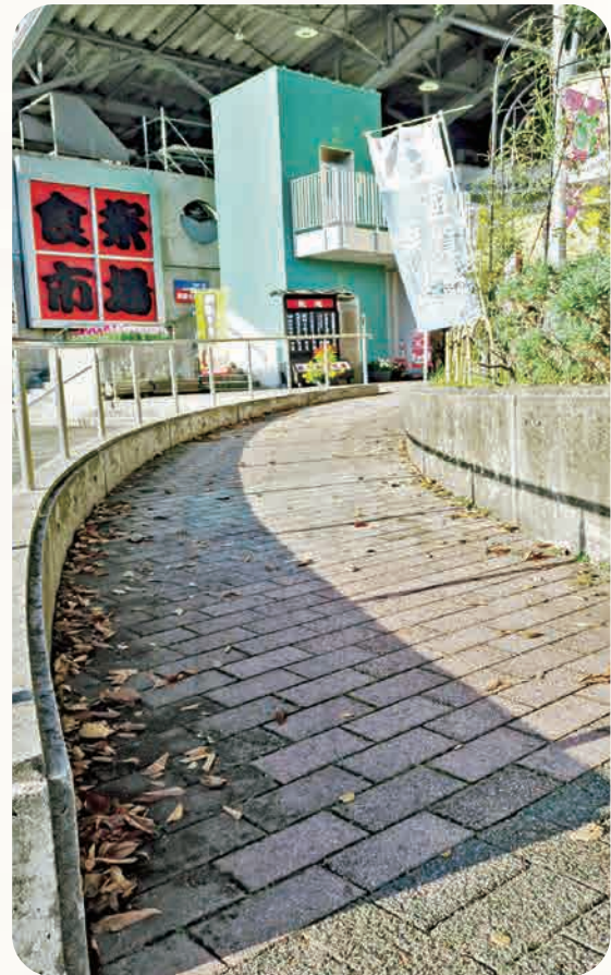
正面玄関に向かうスロープ（全体）
