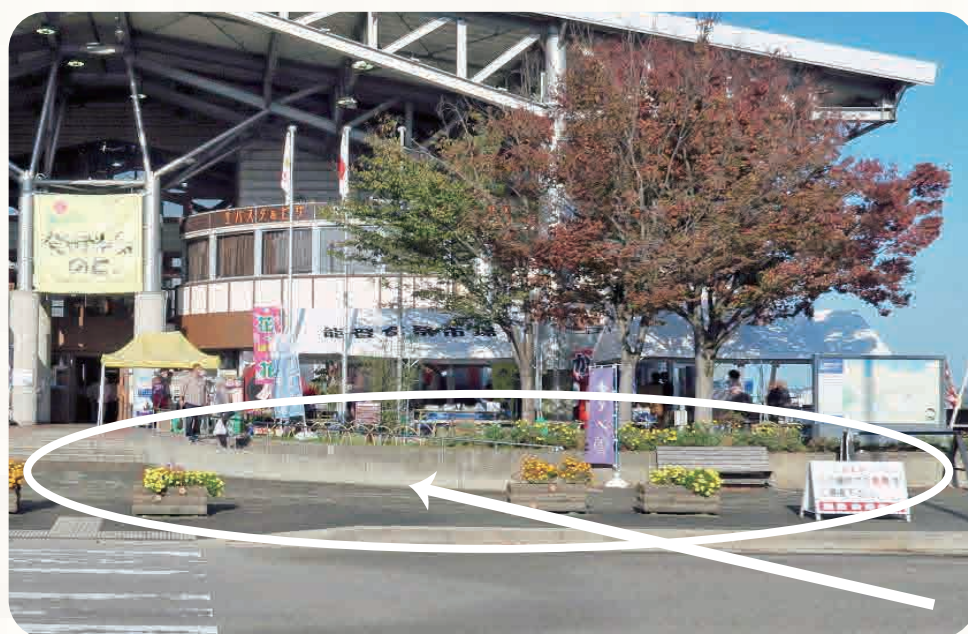
正面のスロープ、登りの正面玄関前
