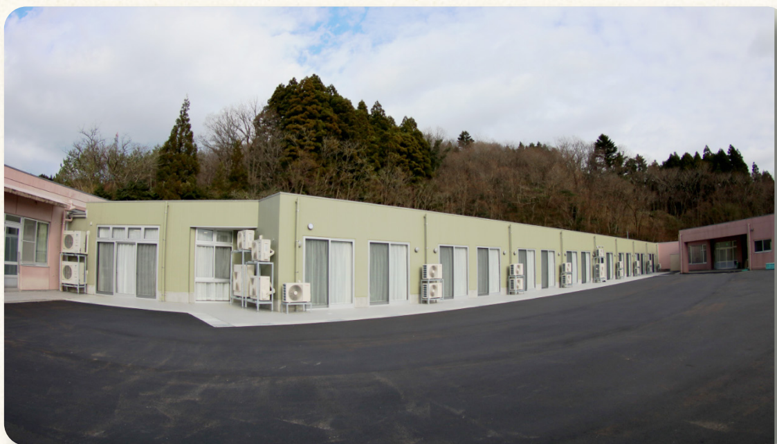
完成したライフサポートセンター個室
