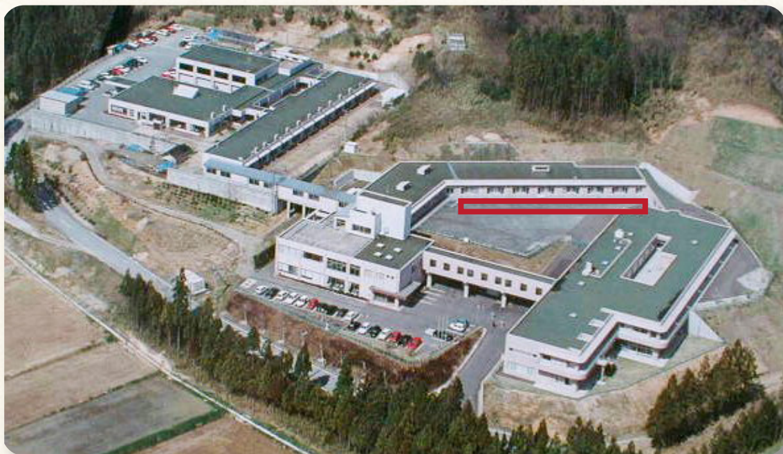
写真上の赤枠の部分に増築工事を行います。
