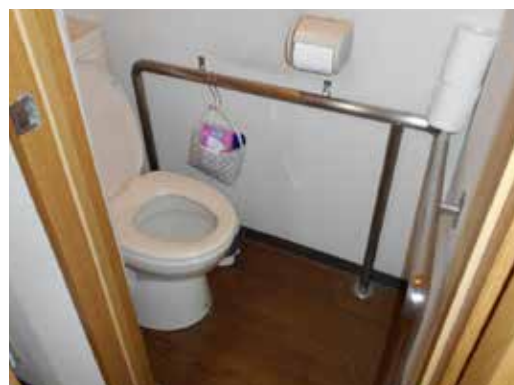
手すりを付けました。
