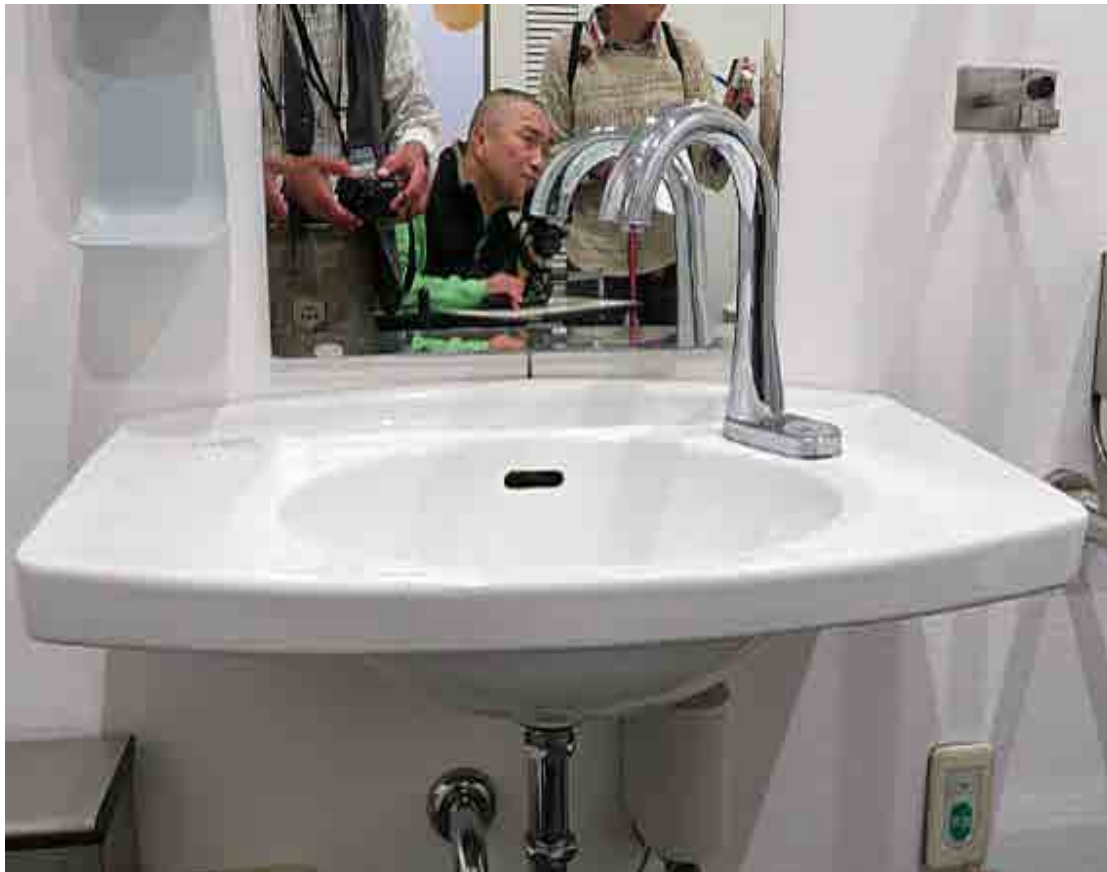
自動給水の手洗い・洗面台
