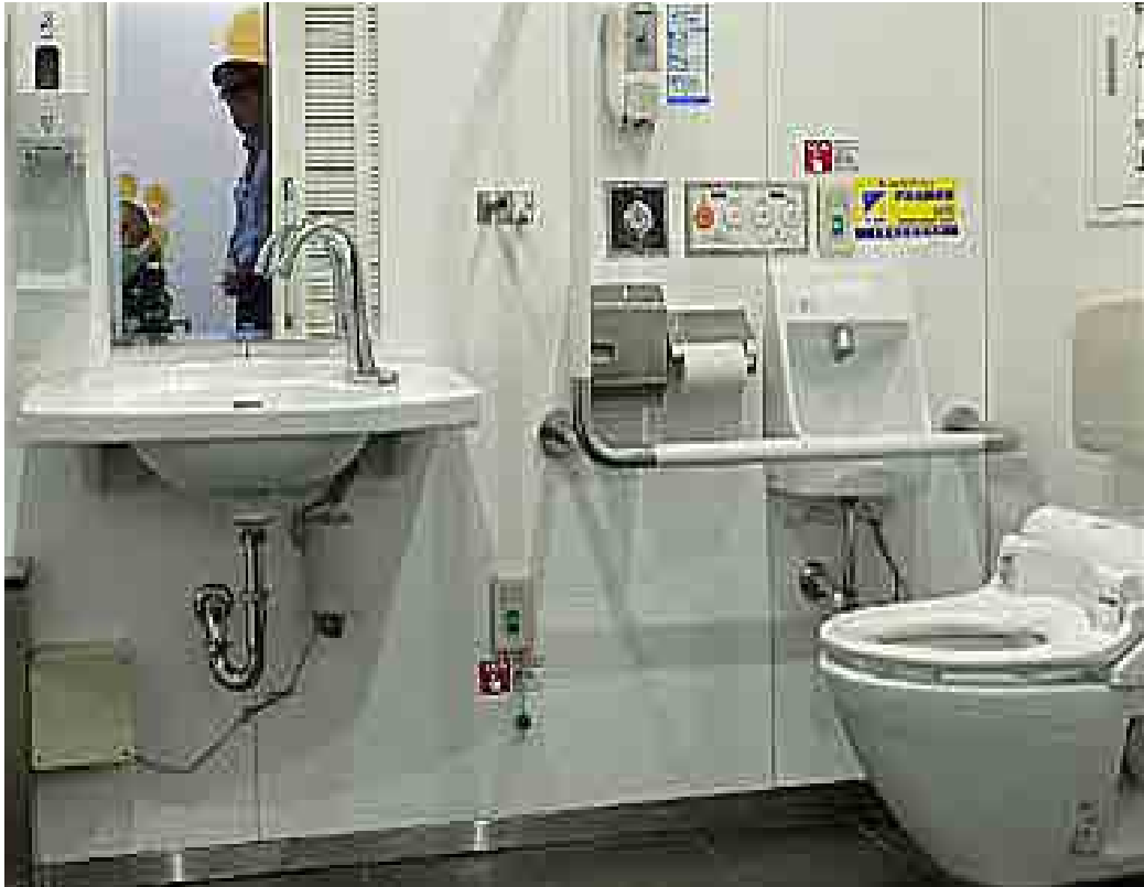
トイレ入り口から全体を撮影。
