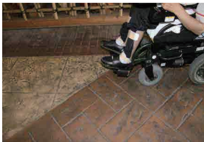
(※写真・改修前「ミナ.クル」床面) ガタガタで歩きにくい
