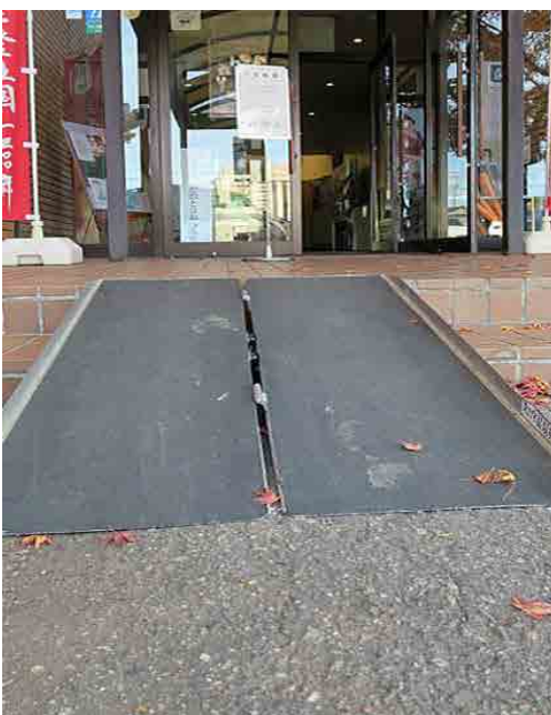
正面玄関にスロープ
