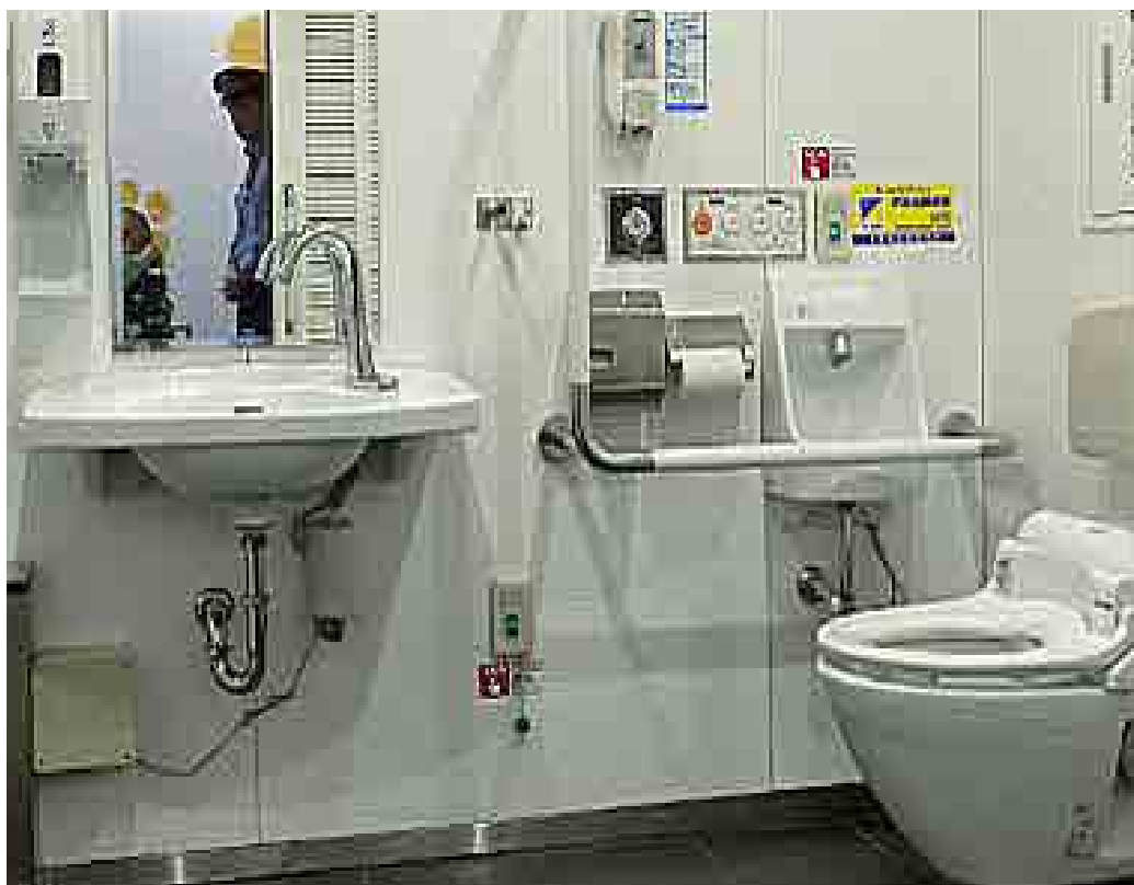
トイレ入り口から全体を撮影。
