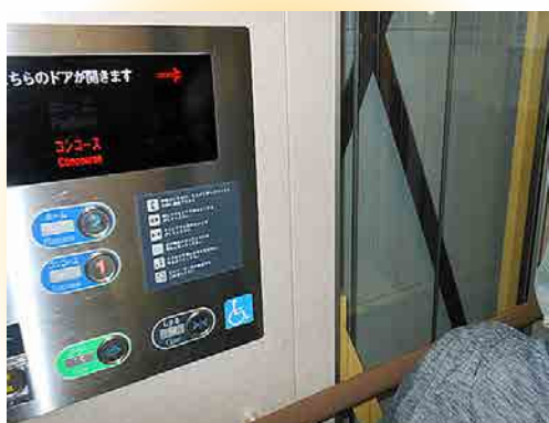
③ エレベーター操作ボタン
