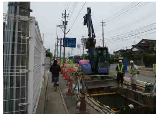
⑥ 大きな穴を掘り工事中
