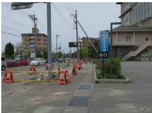
⑤ 電線を地下に埋める工事中
