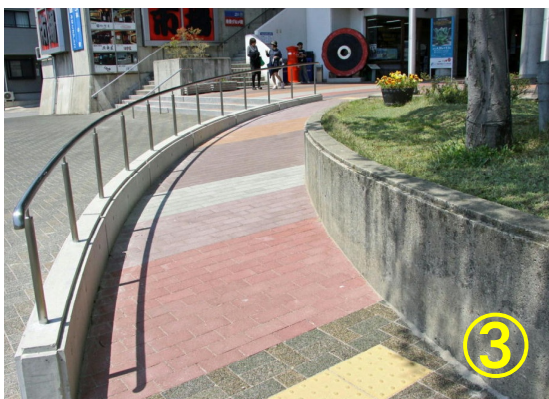
正面に新設したスロープ
