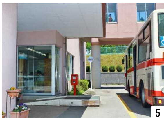
バス乗車用スロープの側面から
