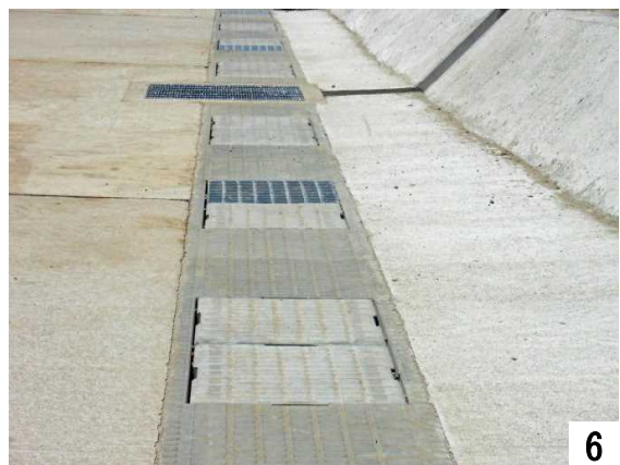
歩道の中央に排水溝があります。
