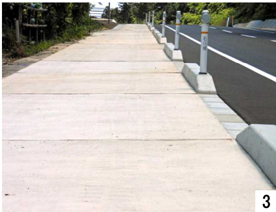
広くなった歩道(直津町方向へ上り坂)
