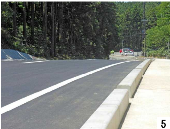
整備された直津町から青山彩光苑方面の道路
