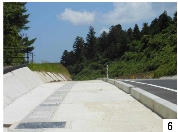
広くなった歩道の頂上へ③
