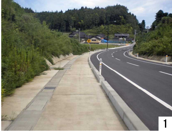
1 車いすも安心して通れる広い歩道
