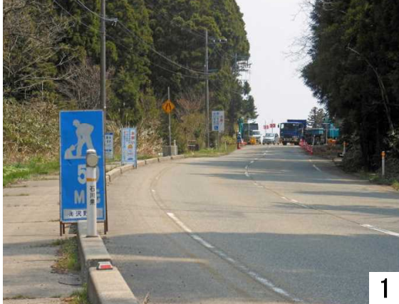
1 彩光苑前から直津町方面の道路工事
