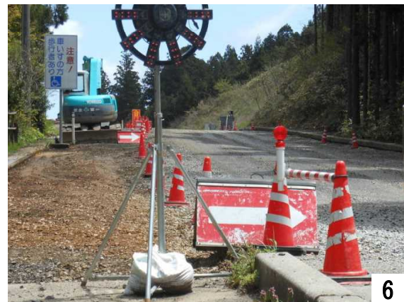
6 歩道工事の間近に近づき撮影。
