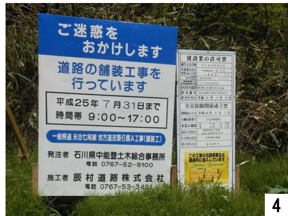
4 道路の舗装工事の許可票
