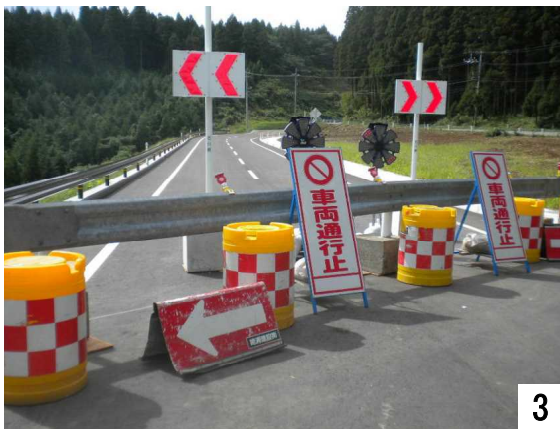
3 未完成部分一部通行止め(迂回路は旧道)
