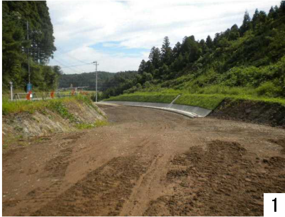
1 青山彩光苑側から直津町方面(未完成)
