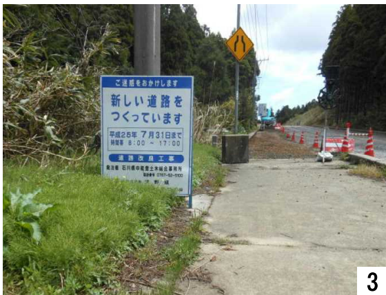
3 新しい道路、歩道を造っています。
