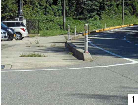
1 駐車場前は歩道がありました……
