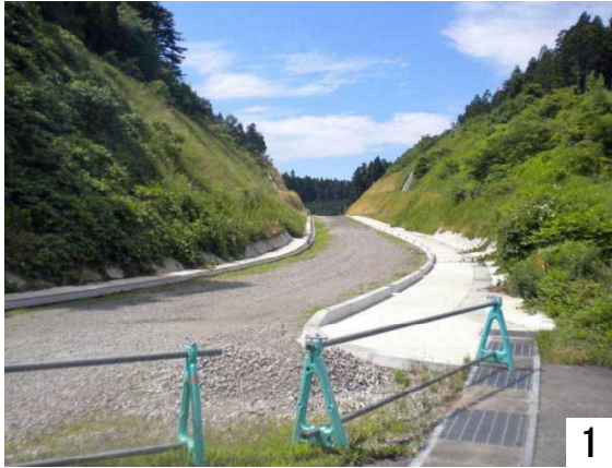
1 直津町交差点の新道路入り口、歩道は舗装済み。
