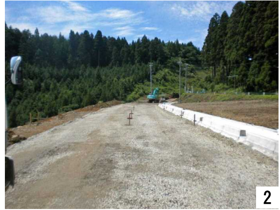
2 道路は砂利を敷き詰めた後。
