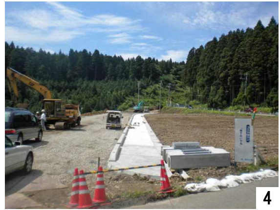
4 舗装工事中(青山彩光苑へ登り方面)
