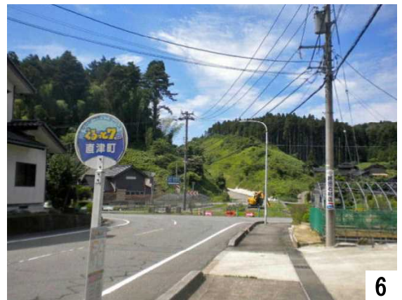
6 直津町バス停から工事中道路を撮影
