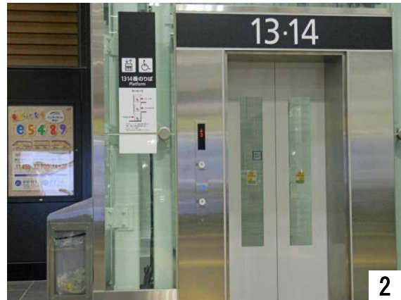
富山駅新幹線ホームエレベーター
