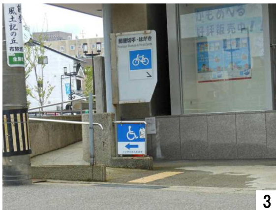
郵便局へ入るスロープ 写真⑤へ
