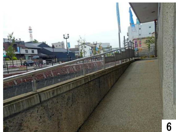
写真③のスロープの上りを撮影
