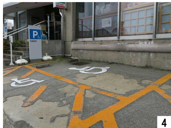
正面の車いす駐車場
