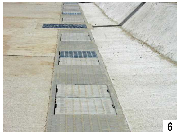
歩道の中央に排水溝があります。
