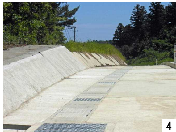
歩道が坂になっています。介助者が必要。
