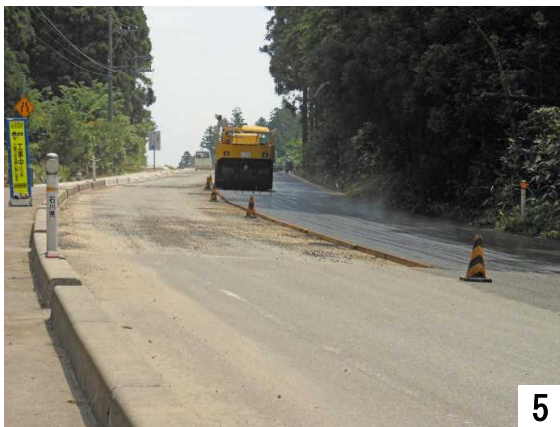
アスファルト合材をローラーで締固め。
