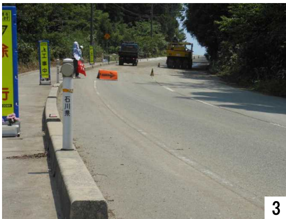
路盤材の敷き込み、ローラーで均等に整備
