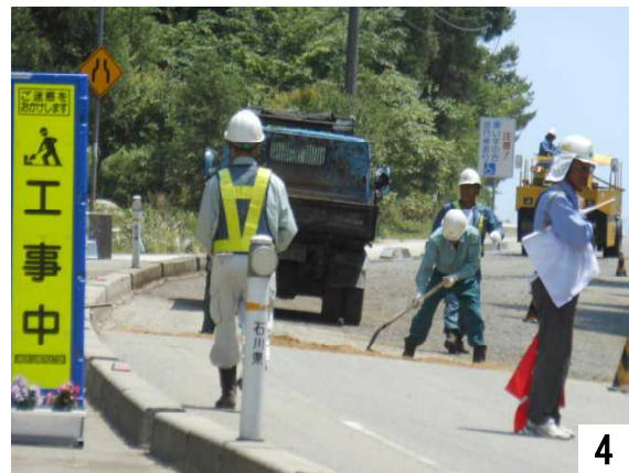
路盤材の敷き込み、端は手作業で丁寧に。
