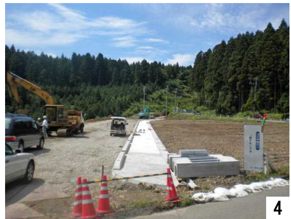
舗装工事中(青山彩光苑へ登り方面)
