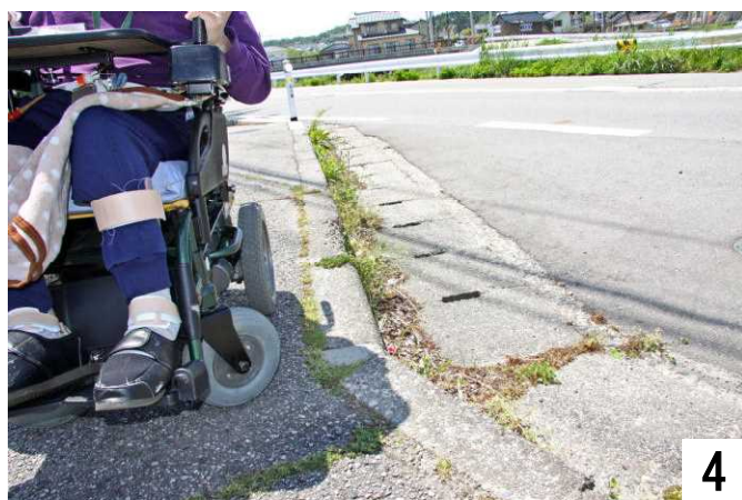
誤操作で脱輪、転倒の危険があり。(前より撮影)
