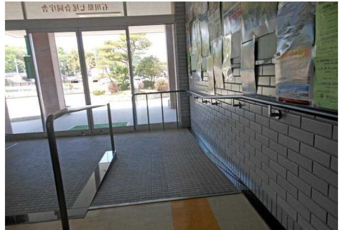
正面玄関にスロープが設置されています。
