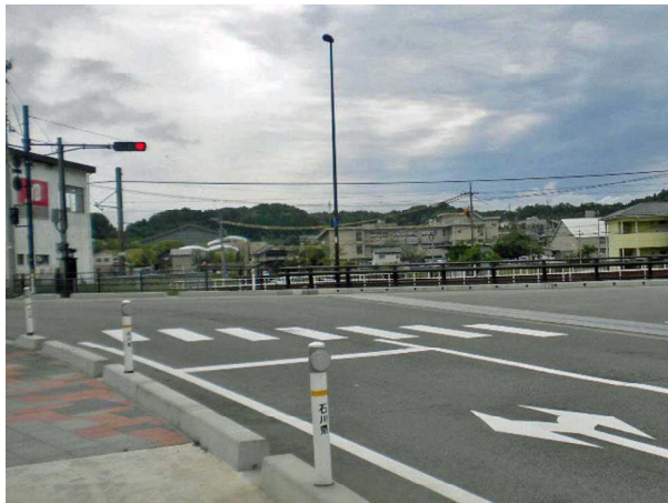
2009年11月14日に完成した「山の寺大橋」小島、和倉方面の分岐点になっています。
