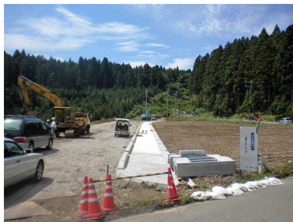
舗装工事中（青山彩光苑登り方面）
