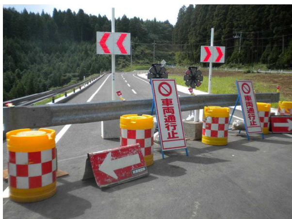
未完成部分一部通行止め(迂回路は旧道)
