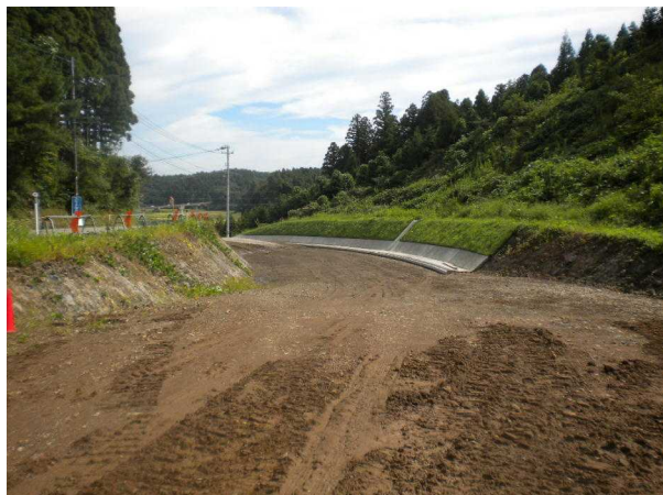
青山彩光苑側から下り方面(未完成)
