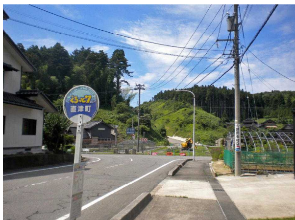
直津バス停から工事中道路を撮影
