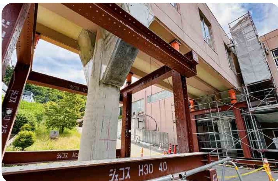
崩落した渡り廊下の足場の修繕工事
