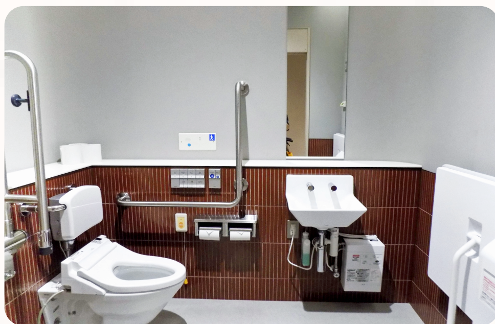
多目的トイレの全体像
