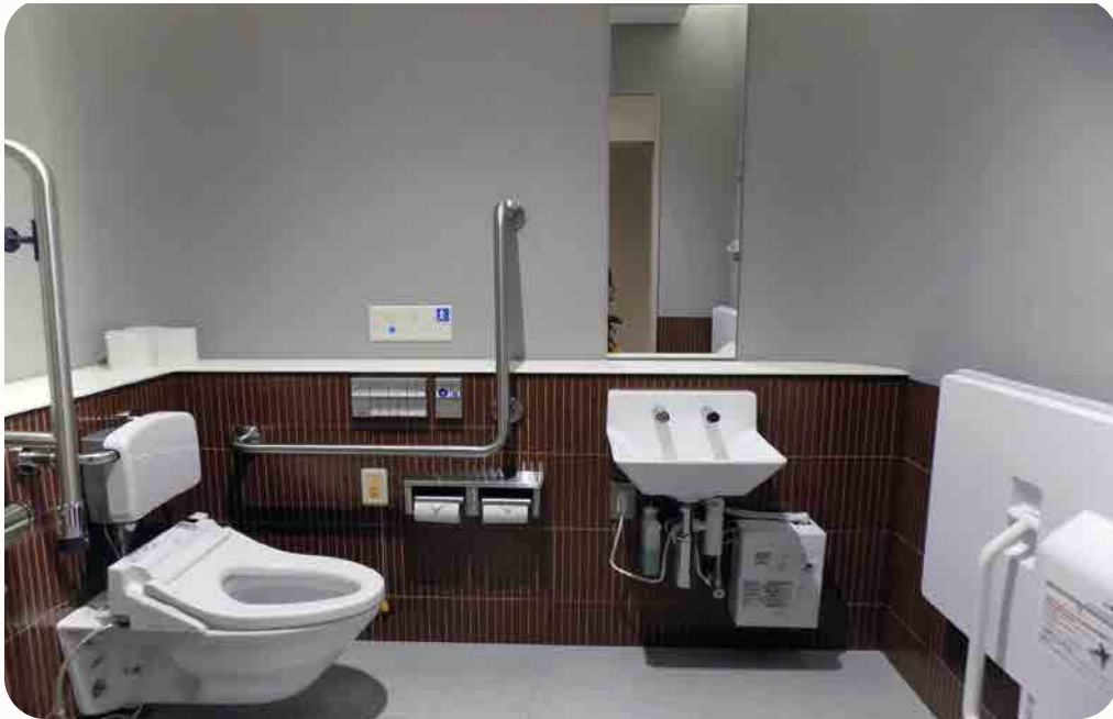
便座、手すり、自動給紙装置の洗面台、おむつ交換台
